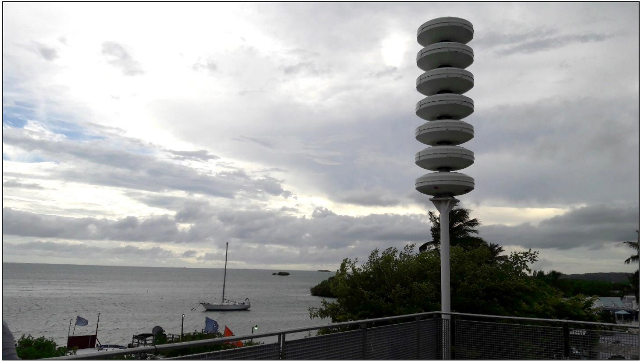
Figura 15: Ejemplo de una sirena fija costera en el municipio de Lajas (La Parguera).
